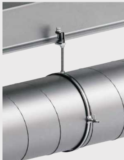
Крепление воздуховода к металлическим конструкциям
